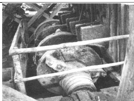
Hävarmar på vattenhulets axel lyfter stamparna med jämna mellanrum
